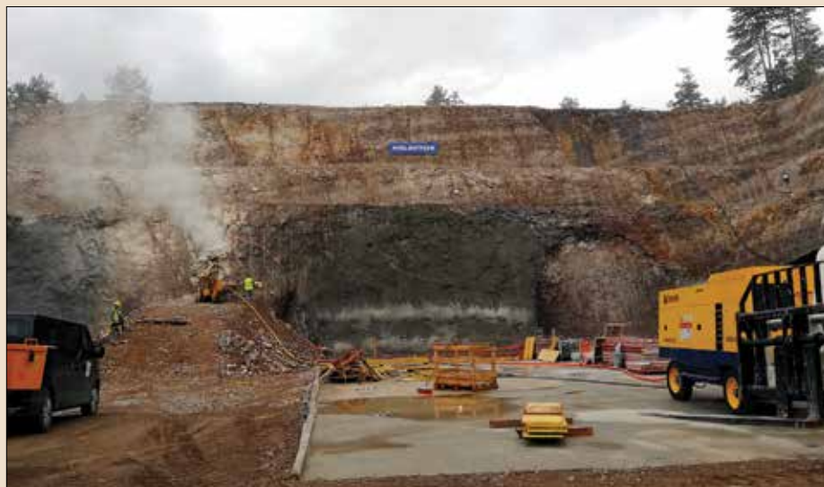
Predvkop predora T1 v bližini Lokve
